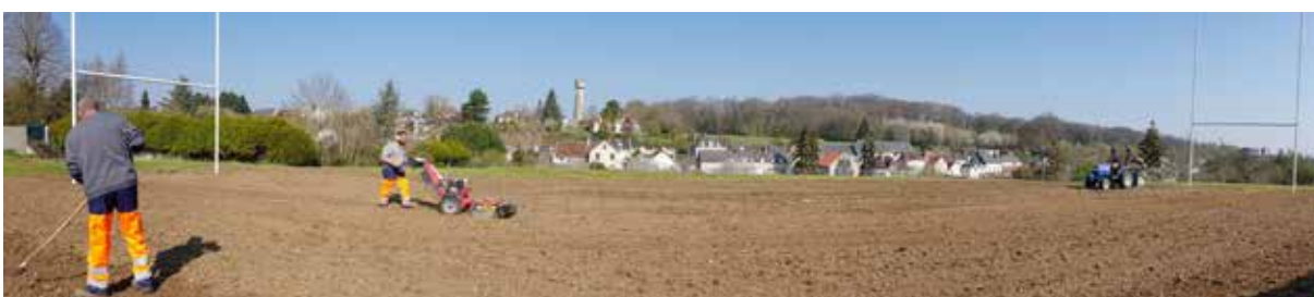
CRÉATION D'UN TERRAIN DE RUGBY - DERRIÈRE LE GYMNASSE
