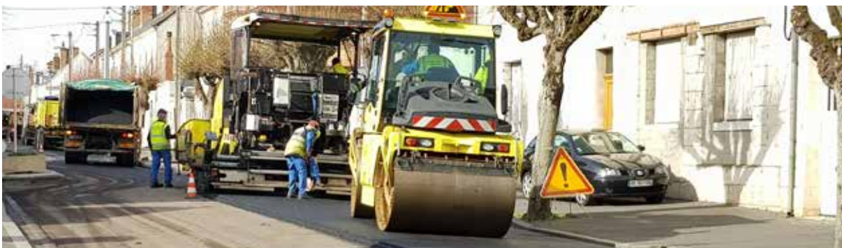
TRAVAUX D'ENROBÉ - AVENUE GAMBETTA
